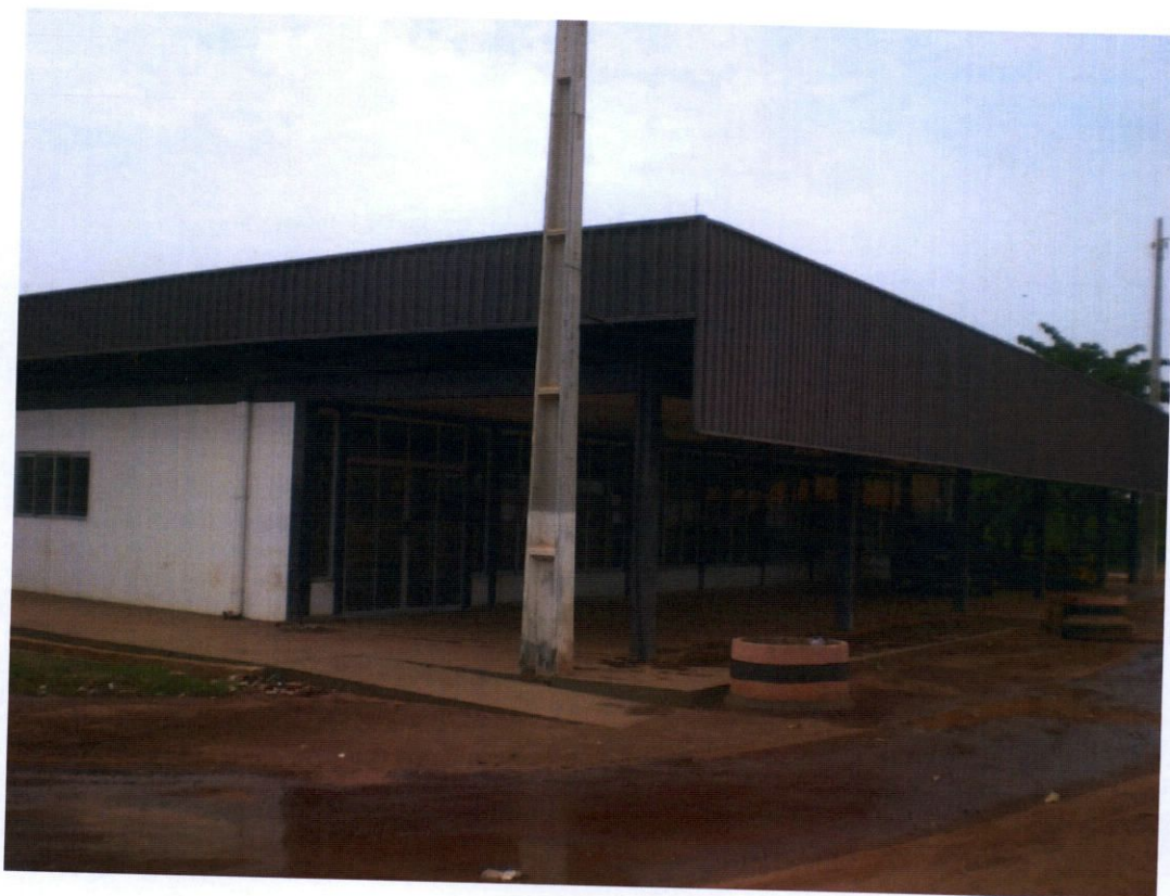
Foto 6 e 7 - Posto Fiscal Antigo reformado e transformado em Restaurante- Lanchonete-Banheiros
