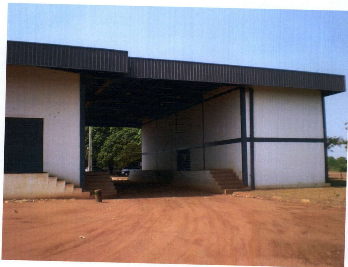
Foto 4 e 5 - Depósito de Mercadorias Reformado e Ampliado - Posto Fiscal de Talismã
