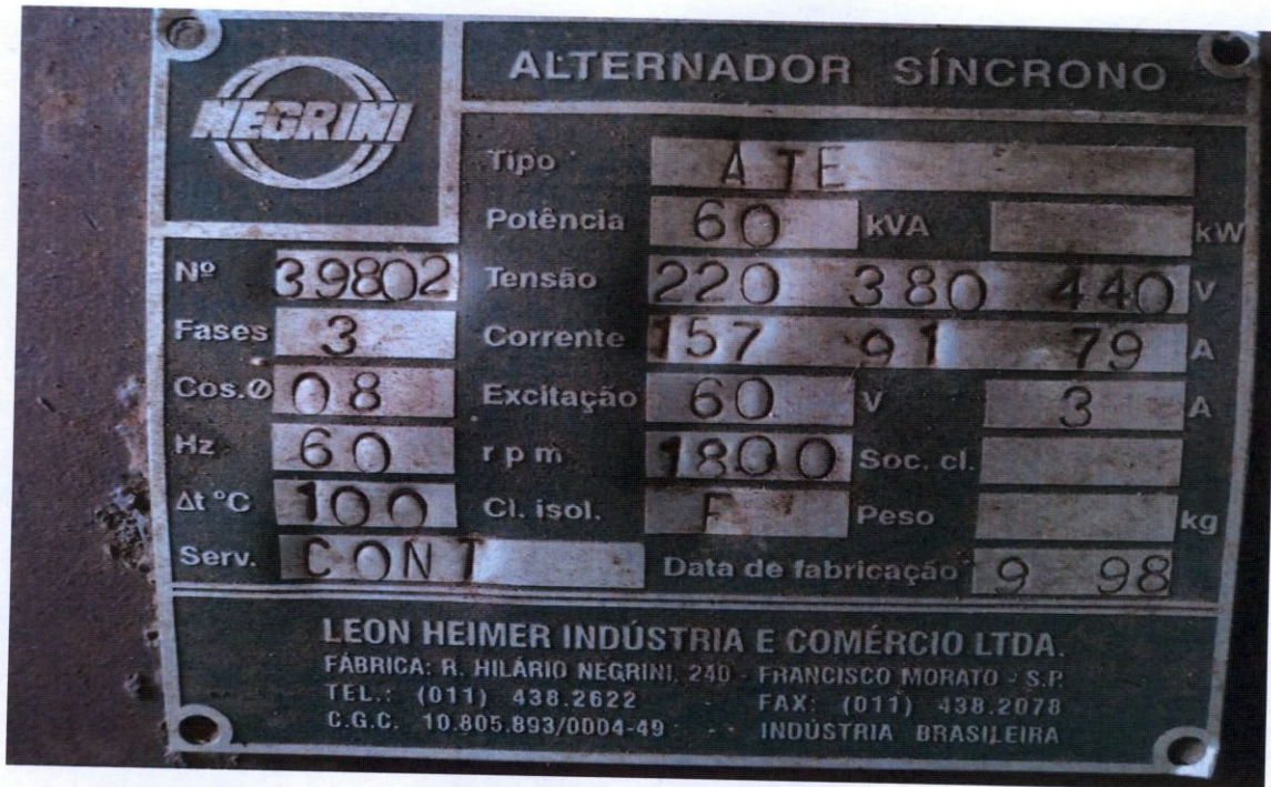
Foto 12 e 13 Plaquetas de Identificação do conjunto motor/gerador adquirido em 1998 do Posto Fiscal de Talismã
